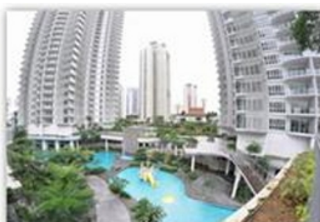
Mount Kiara 28 Condominium KL
